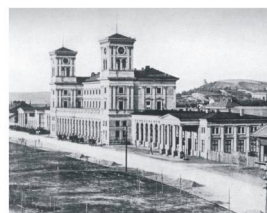
Původní budova nádraží
