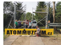
Stavba vstupní brány u silnice Mišov - Borovno
